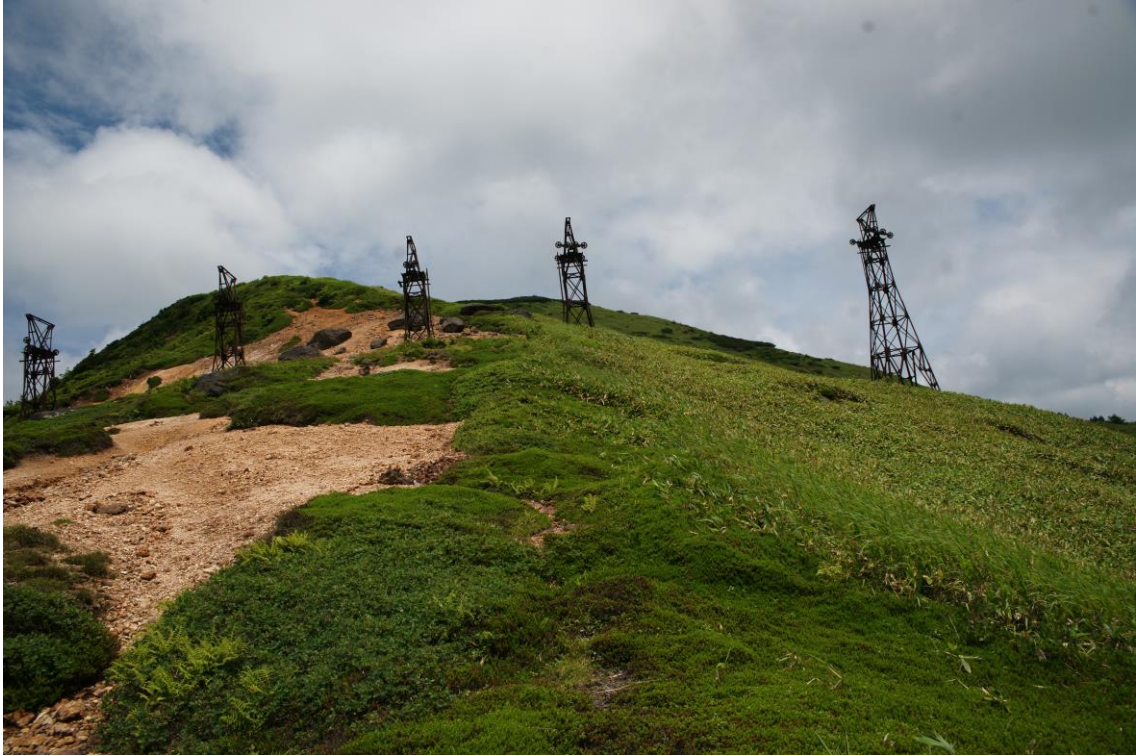
御飯岳(2160m)山頂近くに残る 60 年間放置されている物資運搬用の鉄索の残骸。右が小串鉦山跡、左は高山村
