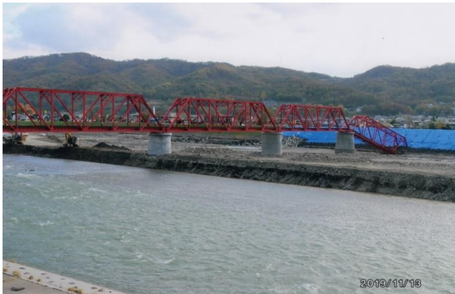
【写真1:崩落した上田電鉄の鉄橋（19.11.13撮影）】
